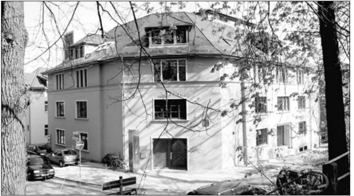
Das Papierlager Ecke Hainstraße/Sellierstraße ist das einzige in seiner ursprünglichen Art weitgehend erhaltene bauliche Zeugnis des renommierten Gustav Fischer Verlages.
