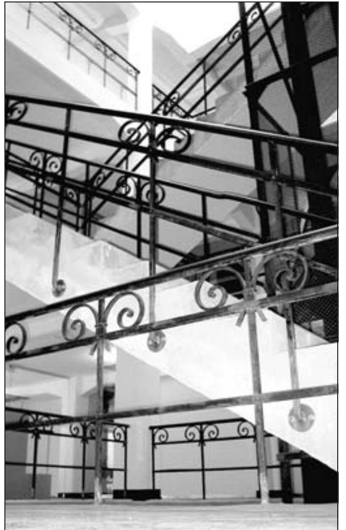
Der alte Treppenaufgang mit dem ornamentalen Geländer ist gemeinsam mit dem Lastenaufzug zentraler Blickfang des sanierten Papierlagers.
